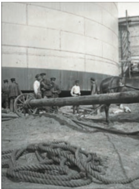
Монтаж нефтяного трубопровода конструкции В. Г. Шухова
