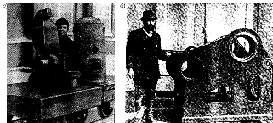
Стальная деталь (а) и станина (б), отремонтированные под руководством Н. Г. Славянова
